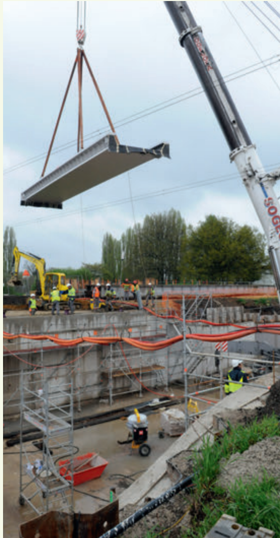
Ci-dessus : pose du pont-rail définitif le dimanche 28 avril dernier.
