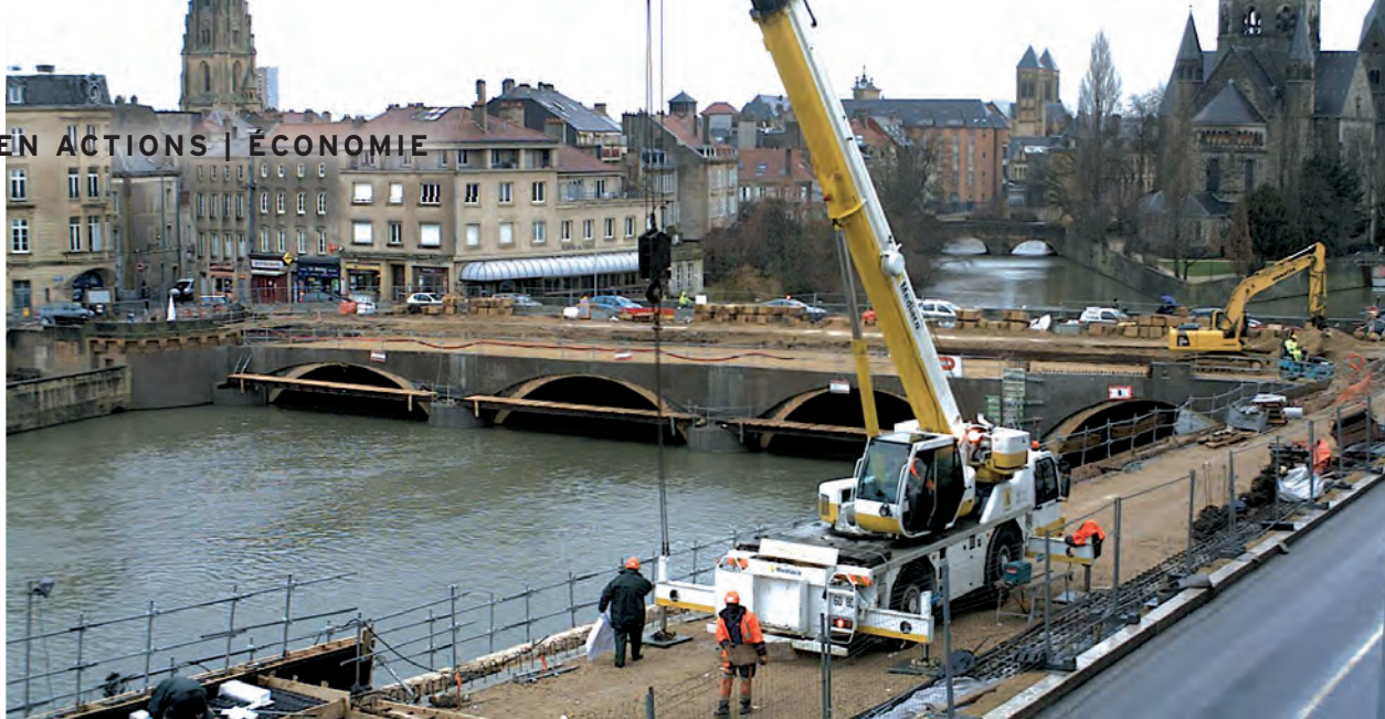
Ci-dessus : le Moyon-Pont, l'un des plus gros chantiers METTIS.
