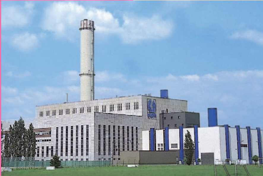
Centrale thermique de Chambière (UEM)
