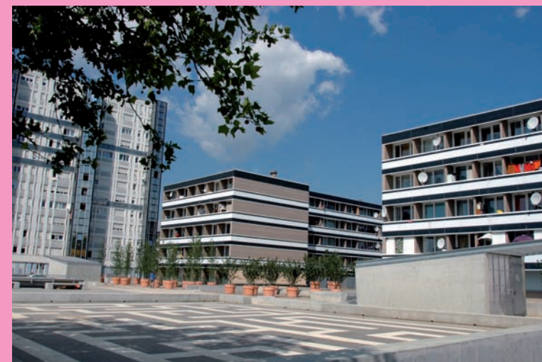
Quartier de Borny, cour du Maine
